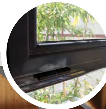
Châssis à soufflet en imposte équipé d'un système à tringle.
