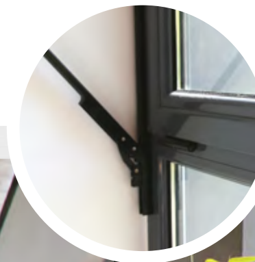
Châssis à soufflet en imposte équipé d'un système à tringle.
