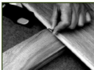
3 • La fixation des lames se fait par clouage en biais avec des pointes à tête plate de 45 ou 50 mm.
