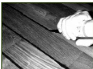
3 • Appliquer le joint mastic noir spécial haute élasticité en fond de gorge entre chaque lame. Le jeu périphérique est également comblé avec ce mastic avec de préférence un fond de joint en mousse. Consommation de joint : 8 mètre linéaire par cartouche de 290 ml soit 0,75 m2 de parquet.
