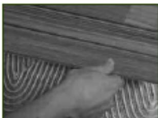
2 • Appliquer la lame dans la colle. Il est important de presser la lame pour une bonne adhérence au sol. Laisser un jeu périphérique de 1,5 mm par mètre linéaire déployé avec un minimum de 8 mm.
