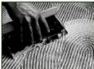
1 • Le support doit être plan. Encoller le support avec **IMPÉRATIVEMENT** notre colle Presto PU, à l'aide d'une spatule crantée 4 X 4 (B3). L'application se fait sur une petite surface et doit présenter un mouvement de stries. Tolérance de planéité : 5 mm sous 2 ml et 1 mm sous 20 cm. Consommation de colle : environ 800gr/m2.
