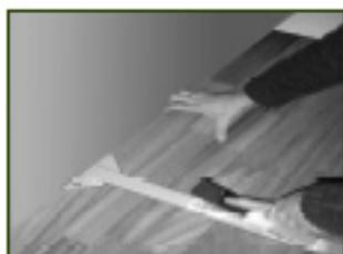
6 • Emboîter la dernière lame avec une chasse métallique. Le recouvrement des joints de dilatation (ou jeu périphérique) s'effectue à l'aide d'accessoires appropriés (plinthes, ronds de radiateur, barre de seuil, etc...)
