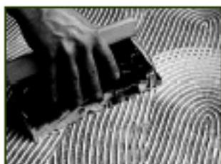
2 • Encoller le support avec la colle préconisée pour chaque type de parquet, à l'aide d'une spatule crantée 4 X 4 (B3). L'application se fait sur une petite surface et doit présenter un mouvement de stries.
