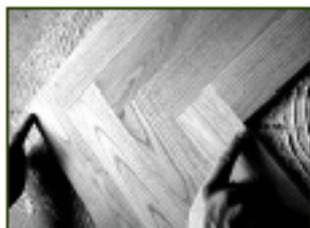
1 • Pour les parquets en panneaux, en bâton rompu ou en Point de Hongrie, démarrer la pose le long de l'axe central de la pièce. Dans le cas d'une pose à l'anglaise ou en coupe de pierre, démarrer dans un angle, rainure contre le mur. Le support doit être plan.
