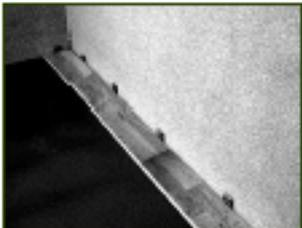
2 • Les lames sont posées parallèlement au plus grand côté de la pièce. La pose démarre dans un angle, rainure contre le mur. Disposez les cales en périphérie. Le jeu de dilatation doit être de 1,5 mm par ml de parquet avec un minimum de 8 mm.
