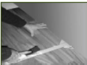
6 • Découper les lames de la dernière rangée à la largeur désirée sans oublier l'espace nécessaire à la dilatation. Utiliser une chasse métallique pour l'emboîtement. Enlever les cales 24 heures après la pose. Fixer les plinthes de finition sans exercer de pression sur le parquet.
