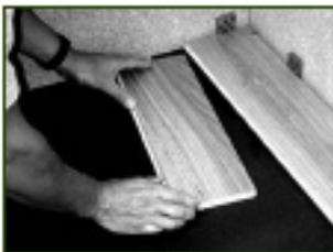
4 • Commencer la 2ème rangée avec la chute de la dernière lame de la rangée précédente. Veiller à ce que la chute corresponde au moins à 2 fois la largeur de la lame pour des raisons esthétiques. Nettoyer aussitôt les traces de colle avec un chiffon ou une éponge légèrement humide.
