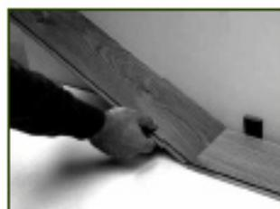
3 • Incliner la 2ème lame dans la précédente pour l'emboîtement et la plaquer au sol. Ajuster la jonction en bout avec un marteau et un martyre.
