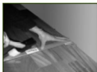
6 • Pour le dernier rang, emboîter les lames à plat à l'aide de la chasse métallique.
