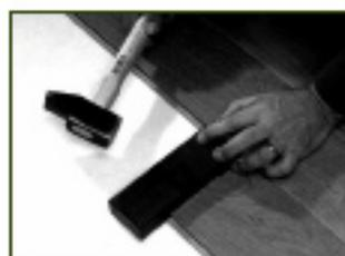
5 • Si nécessaire, frapper en bout en utilisant un martyre ou une cale de bois pour ne pas abîmer le bord.
