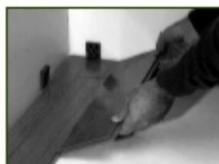
4 • Récupérer la chute du 1er rang pour le démarrage de la 2ème rangée. Rabattre la lame et encliquer en fin de rotation.
