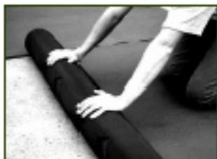
1 • Dérouler la sous-couche isolante ISOL 30 sur le support plan et sec. Les lés sont scotchés entre eux bord à bord et remonte le long des murs.
