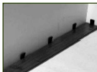
2 • Débuter la pose dans un angle, en partant de la droite, face au mur. Positionner la lame, côté languette contre le mur (languette à découper pour respecter le jeu de dilatation). Disposer les cales dans le jeu de dilatation.
