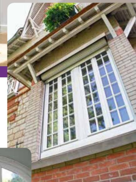
Bavette permettant de recouvrir l'appui existant
